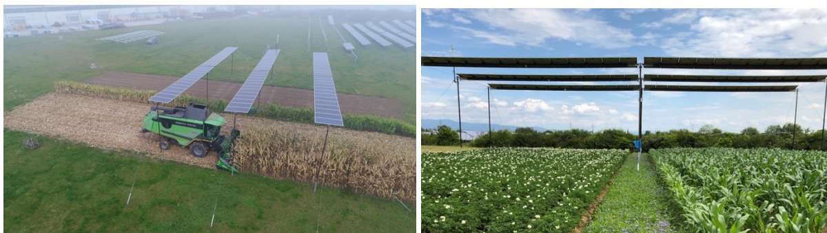
Abbildung 77: Forschungsanlage HyPERFarm - Seilaufhängung der Firma Krinner Carport GmbH.
