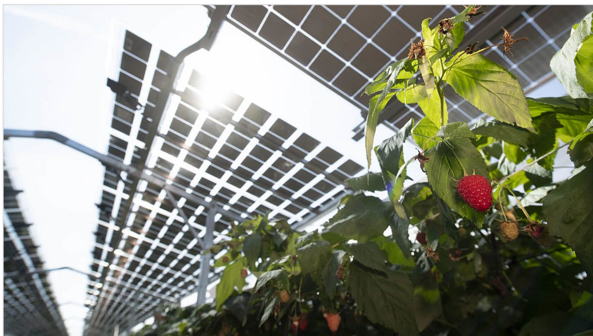
Abbildung 30: Semitransparente Module, hier als Überdachung für Himbeeren, Niederlande (BayWa r.e., 2021).
