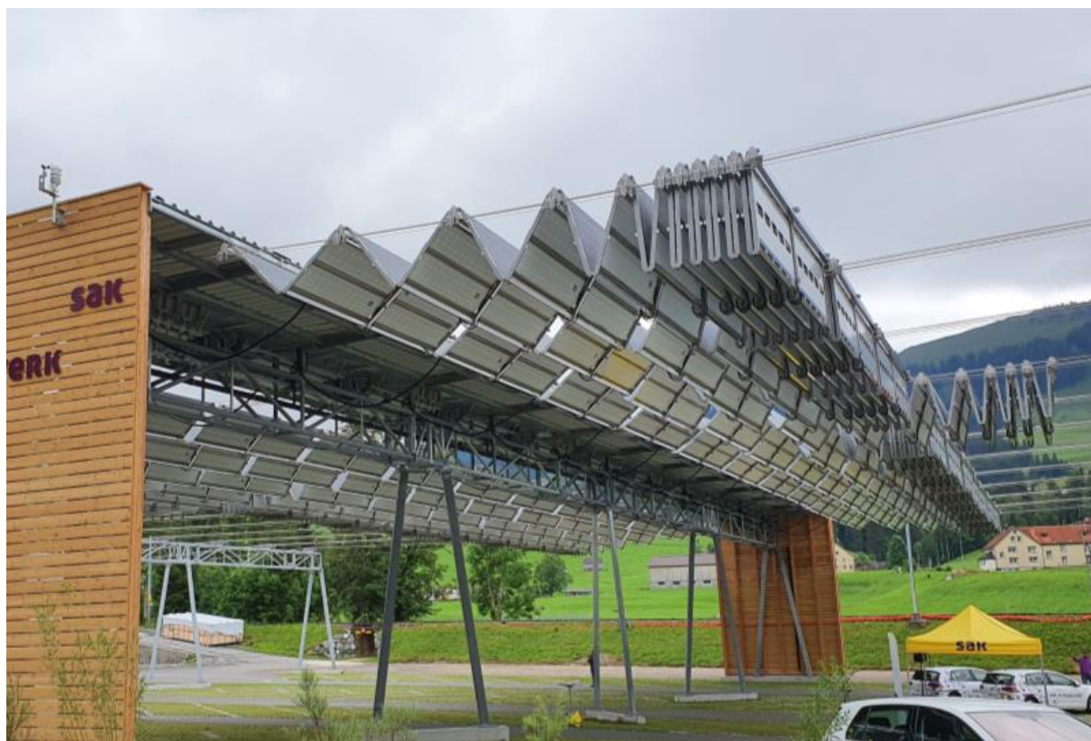
Abbildung 25: Beispiel einer Faltdachanlage mit Solarmodulen, kommerziell bereits über Parkplätzen und Infrastrukturanlagen (DHP, o.J.).
