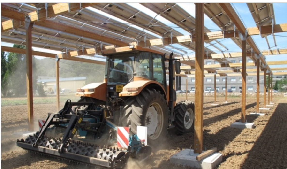
Abbildung 26: PV-Anlage mit Aufständering aus behandeltem Holz, Montpellier Frankreich (Dupraz, 2020).
