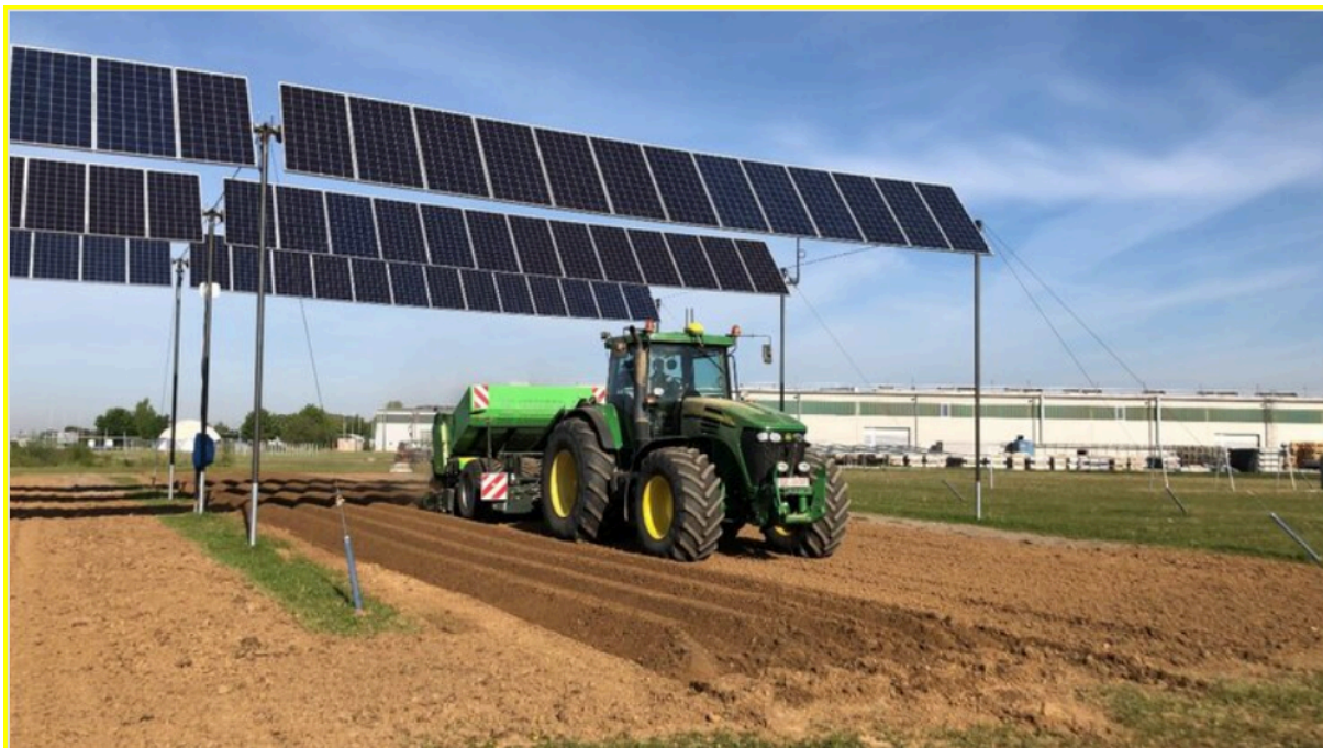
Abbildung 24: Pilotanlage mit abgespannter Seilaufhängung in Straßkirchen, Bayern (Krunner Carport GmbH, Harlander, 2021).
